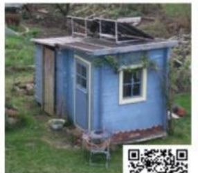
Auf dem Dach aufgeständert
