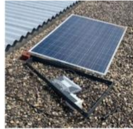
Auf dem Dach liegen, Eigengewicht
